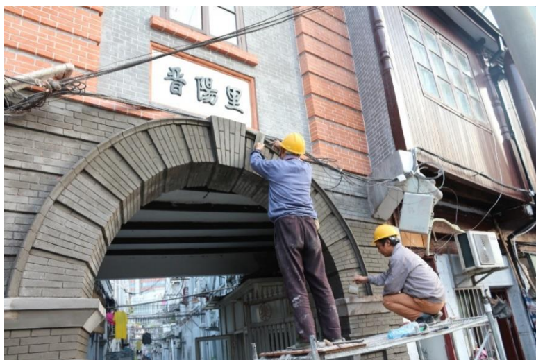
圖十 風貌區中的公房弄堂口正在進行例行維護，以水泥仿製磚牆 （圖片來源：本研究 2018/10/24 拍攝於楊樹浦路）
