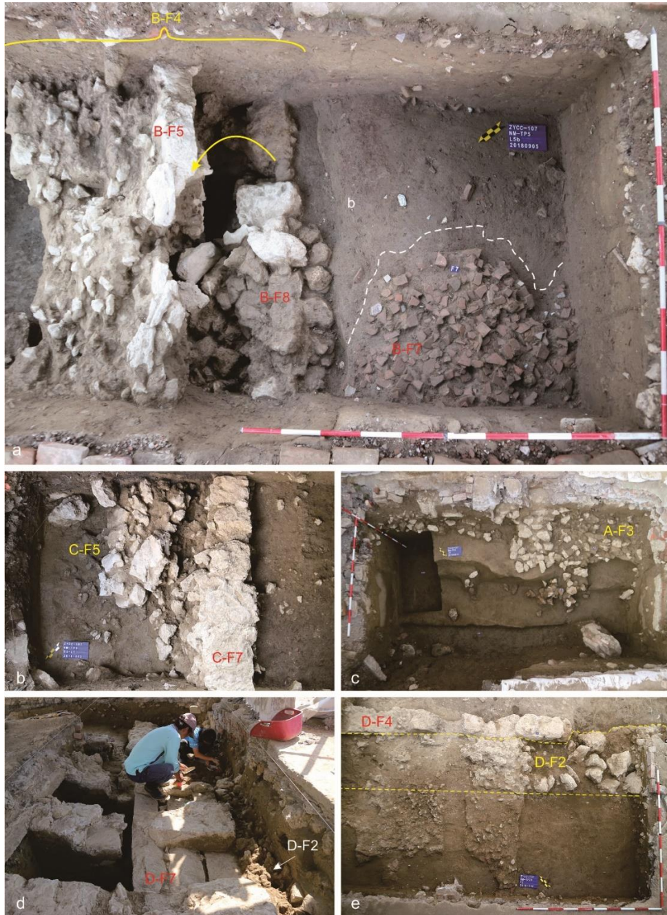
圖版二 日治時期拆毀南門段城牆的行為與遺跡 (a. B 區域牆內壁牆體殘留基礎 B-F8 與日治拆牆扳倒填埋的城牆內壁牆體 B-F5。b. C 區域牆內壁牆體殘留基礎 C-F7 與日治拆牆填埋城牆內壁牆體的凹溝 C-F5。c. A 區內壁牆體被拆毀堆覆狀態的 A-F3 遺跡。d. D 區水關 (D-F7) 與外壁牆體拆毀填埋的 D-F2 遺跡。e. D 區北側外壁牆體 (D-F4) 被拆毀填埋的 D-F2 現象。)
